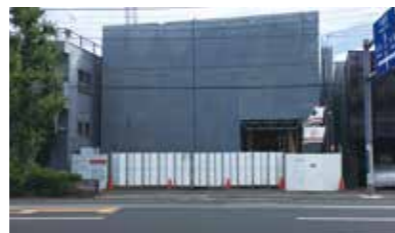
(仮称)藤崎三丁目・六郷ダイヤ川崎計画新築工事 現地▶川崎市川崎区藤崎3丁目区 構造▶RC造 階数▶地上7階 用途▶共同住宅・倉庫・駐車場 戸数▶2DK 12戸、1K 24戸
