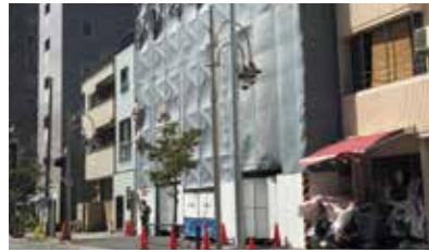
オークテラス建設工事 現地▶川崎市幸区南幸町1丁目 構造▶RC造 階数▶地上10階 用途▶共同住宅、事務所 戸数▶19戸
