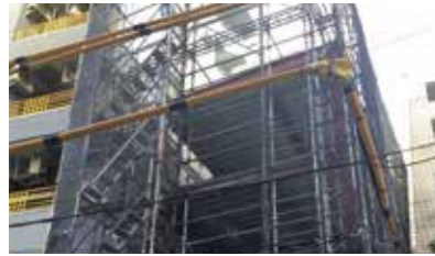
M's HEIGHTS ANNEX 現地▶東京都大田区大森北1丁目 構造▶S造 階数▶地上4階 用途▶事務所・共同住宅 戸数▶4戸
