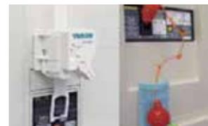
ばねの作動やおもりの落下によりブレーカーを落として、電気を遮断。
